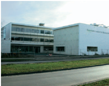
Eingangsbereich des Neubaus und Ansicht von Süden im November 2006
